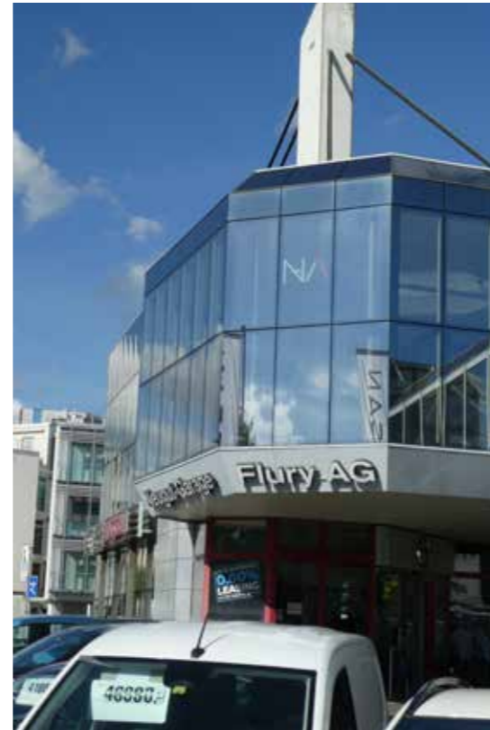
Die Garage Flury in Wallisellen.
