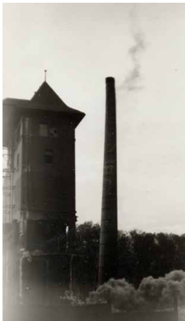
Der Hochkamin am Tag seiner Sprengung, kurz nachdem die Sprengladung gezündet wurde. Gut sichtbar der Pulverdampf und die aufgewirbelte Staubwolke. Der Schlot neigt sich schon ein bisschen nach rechts und liegt Sekunden später in tausend Scherben am Boden.
